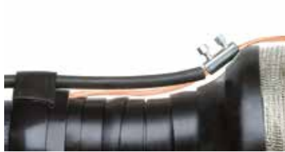
Połączenie z wyprowadzeniem uziemienia
