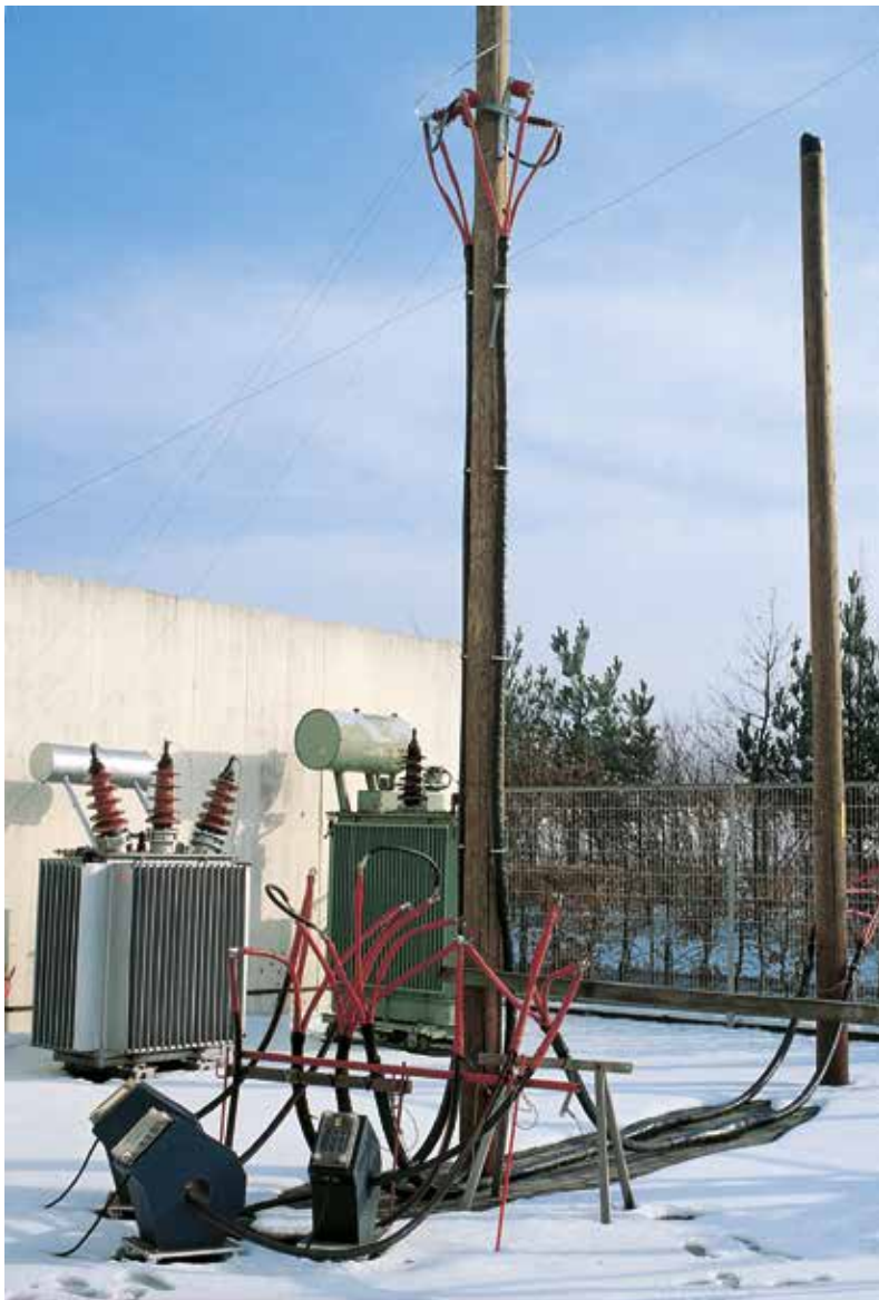
Badania osprzętu kablowego typu GUSJ i GUST na kablach o izolacji papierowej na napięcie 10 kV w centrum rozwoju TE Raychem
